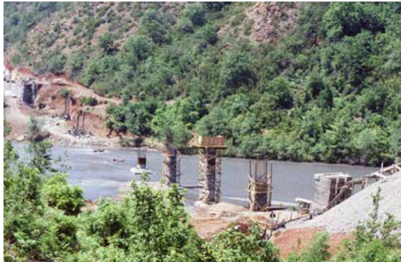
Die zukünftige Eisenbahnbrücke über den Fani i madh. Foto: Jochen Blanken
